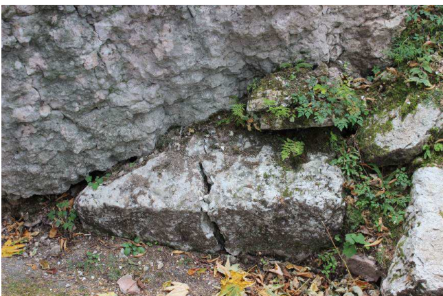
Foto 3.3.2 e 4.3.2: da sinistra la fessura di un blocco alla base del grande masso in "avanzamento" sulla strada a novembre 2017 e ad aprile 2018. In poco più di 4 mesi la fessura si è aperta di qualche millimetro, mentre lo spostamento del blocco sovrastante è dell'ordine dei centimetri.
