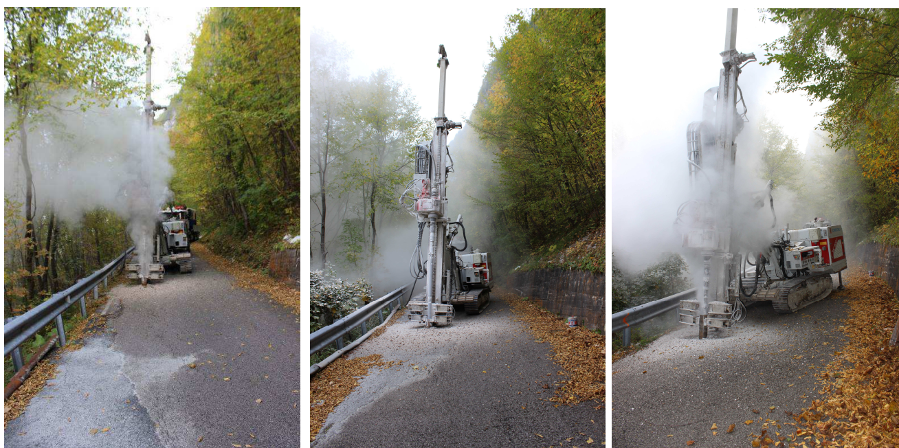
Foto 2.4.1 e 3.4.1: da sinistra i sondaggi S1 S2 e S2. Il primo mostra la roccia (Dolomia Principale) ad una profondità di 4.70 m dal p.c., il secondo a 4.50 m ed il terzo a 3.50 m. La copertura è costituita da detrito calcareo e calcareo – dolomitico arido e compatto, solo in prossimità del contatto con il substrato caratterizzato da un elevato tenore in matrice fine limosa marrone – rossastra e da condizioni di “umidità”.
