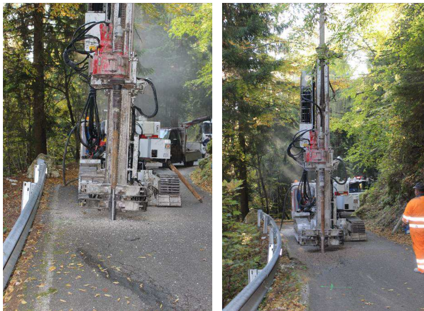
Foto 2.3.1 e 3.3.1: da sinistra i sondaggi S1 e S2. Il primo mostra la roccia (Calcari Grigi di Noriglio) ad una profondità di 2.30 m dal p.c., il secondo a 2.80 m. La copertura è costituita da detrito calcareo e calcareo – dolomitico arido e compatto, solo in prossimità del contatto con il substrato caratterizzato da un elevato tenore in matrice fine limosa marrone – rossastra e da condizioni di “umidità”.
