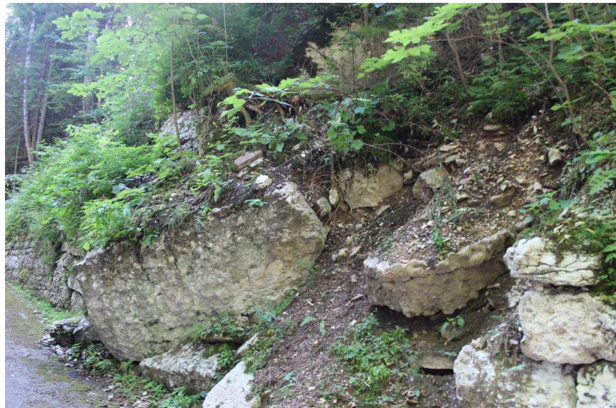
Foto 1.3.2 e 2.3.2: vista panoramica e ravvicinata sulla "punta" più avanzata della frana che interessa il versante a monte della strada (zona di intervento 2). Grossi trovanti di Rosso Ammonitico "galleggiano" sul detrito che colma la valletta sepolta.
