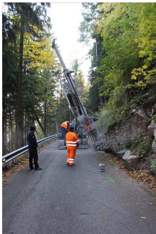
Foto 5.3.2 e 6.3.2: da sinistra i sondaggi S1 e S2. Il primo mostra la roccia (Calcari Grigi di Noriglio) ad una profondità di 9 m sull'inclinata, in S2 la roccia è a 7.50 m. In entrambi la copertura è ricca di matrice, in particolare dalle profondità di 4.50 m, oltre le quali il terreno è saturo.
