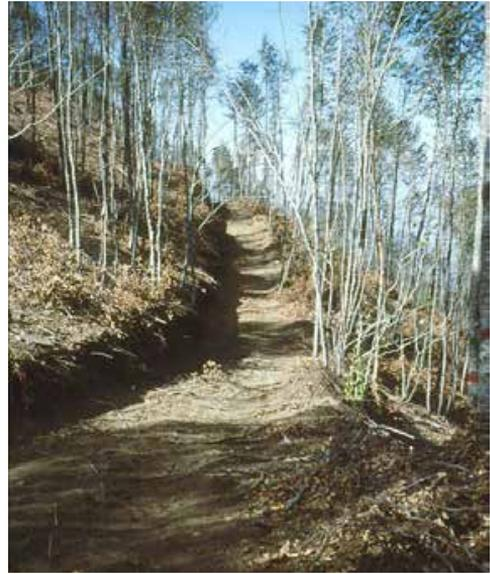
Img. 73 *Pista permanente, o principale, di esbosco*
